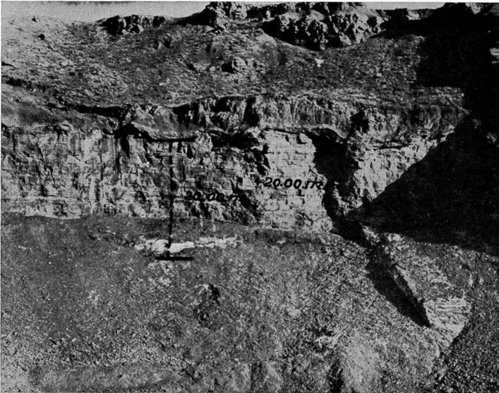
Foto VI — Kağızman Kayatuzu Açık işletmesi (Tuz tabakası 20.00 m. kalınlıkta) La Mine de Sel Gemme de Kağızman exploitée en découverte (les couches de sel gemme présente une épaisseur de 20.00 m.)
